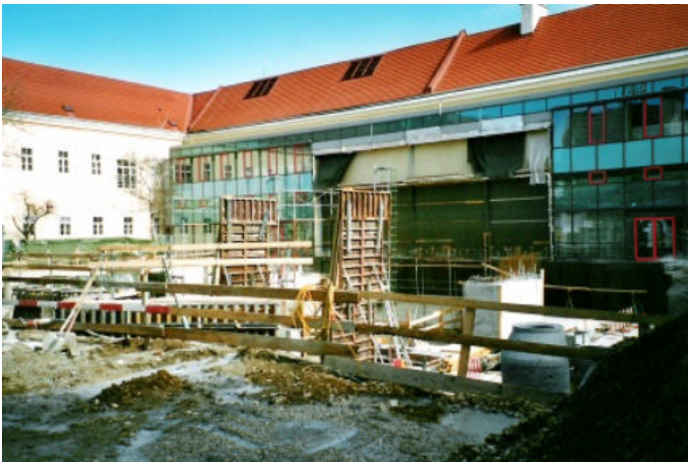
Abb. 29: Hörsaalzentrum im Bau, Hof 2
