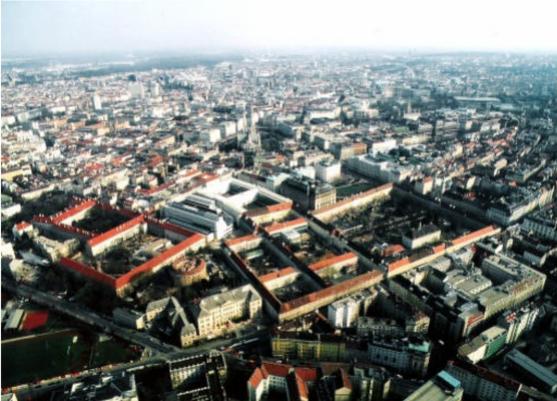
Abb. 2: Luftaufnahme von Wien mit dem Universitätscampus, erkennbar an den charakteristischen, lang gestreckten, Höfen umschliessenden Baukörpern, vor dem Umbau 1995
